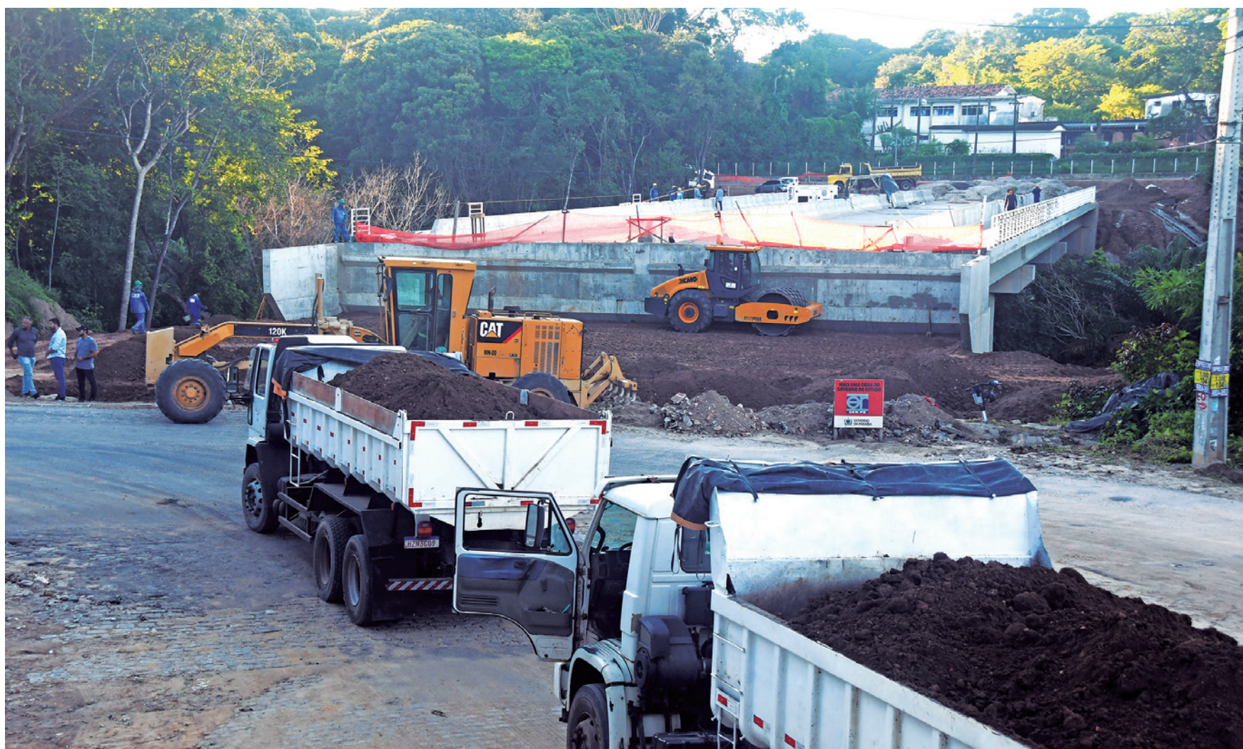
Quando concluída, a ponte, que tem orçamento de R$ 12,3 milhões do Governo do Estado, terá 80 metros de comprimento, 15 de altura e 25 de largura
